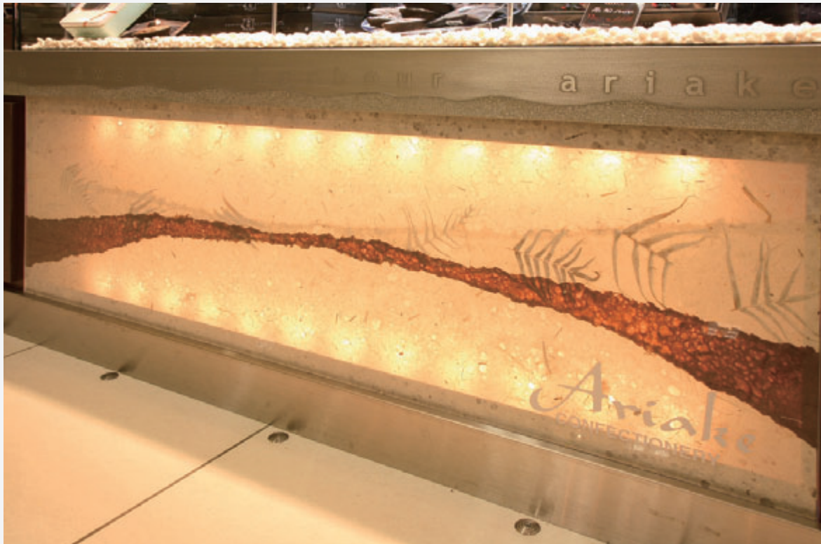
金属溶射=錫=カウンターロゴ入グラデーション仕様：腰パネル内照式組和紙アクリル板サイン
