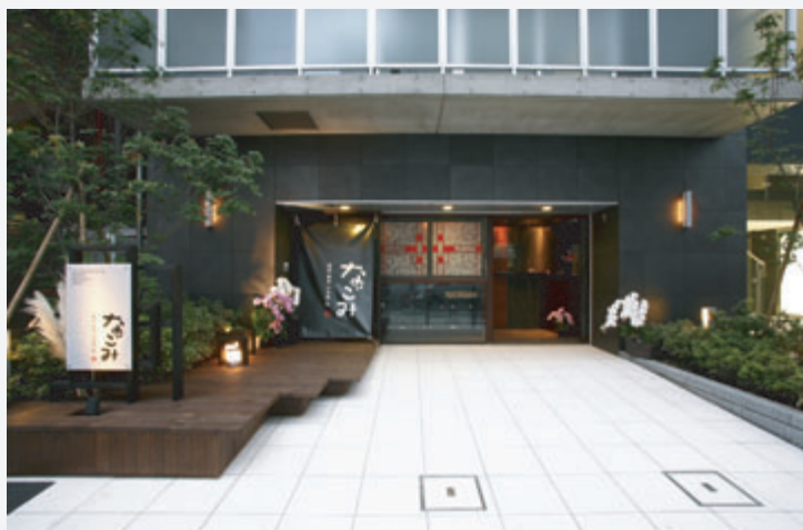
エントラス正面夕景
